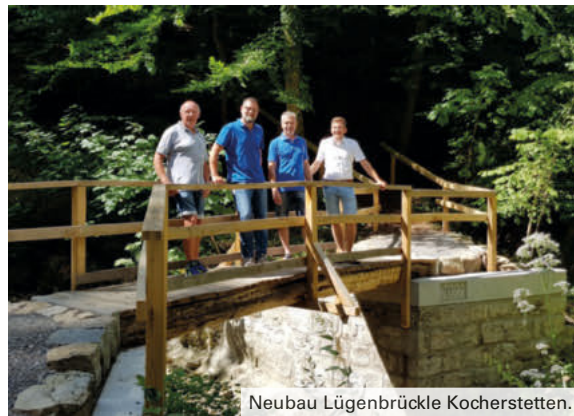
Neubau Lügenbrücke Kocherstetten.
