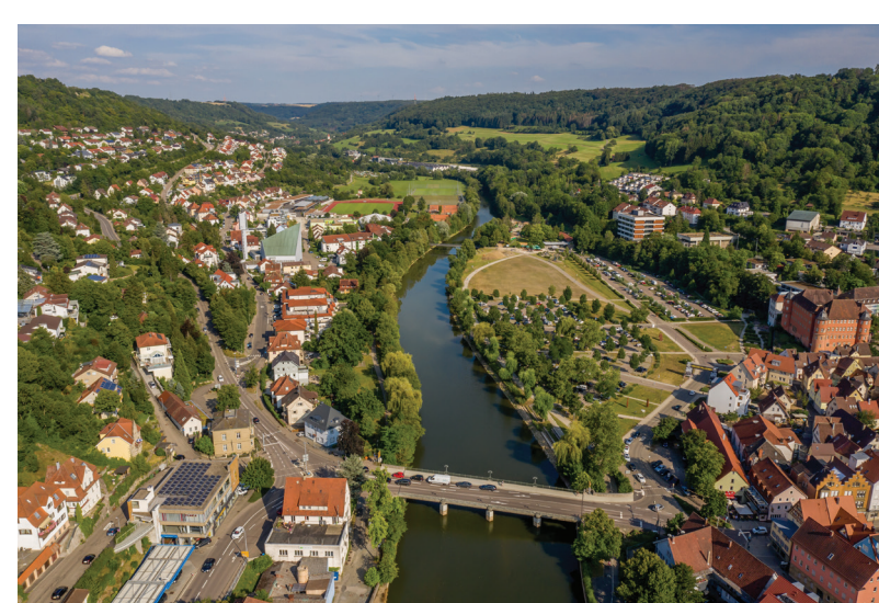
Am nördlichen, im Bild linken, Kocherufer wird in den nächsten zwei Jahren an Entwässerung und Umweltschutz gearbeitet.
